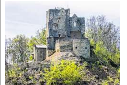
In den Burgmauern stecken viele freiwillige Arbeitsstunden. Foto: Lienert
