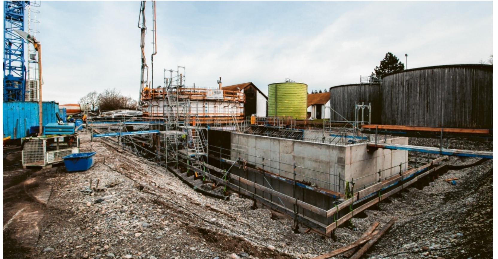
Große Fortschritte macht der Bau des Faulturms mit Betriebsgebäude in Oberottmarshausen. Foto: Jürgen Schmidt
