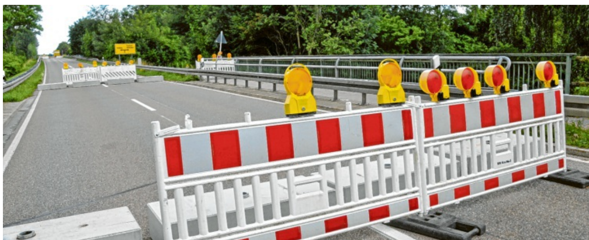
Wegen Schäden an der Brücke über die Roth ist die Staatsstraße 2021 in Pfaffenhofen zwischen dem Kreisverkehr am Gewerbegebiet und Einmündung Hauptstraße (Ortseingang Nord) gesperrt. Google Maps hat dies bereits registriert. Foto: Roland Furthmair
