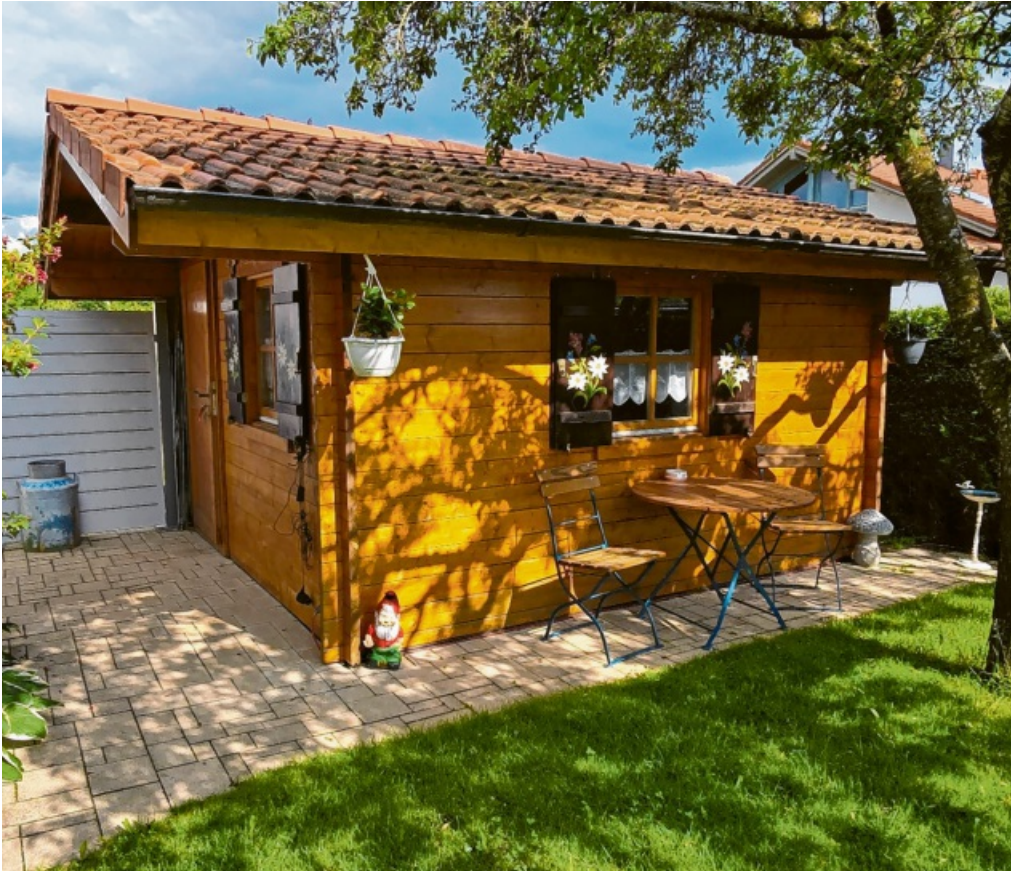
Die Gartenhütte der Familie Satzger muss abgerissen werden. Das hat die Stadt verfügt.
